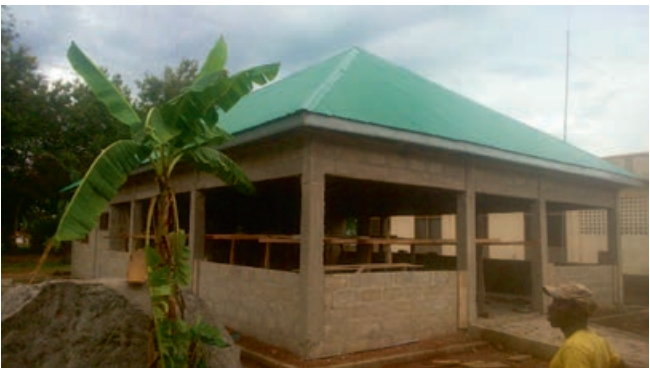
Rohbau des Outreach-Postens in Traboum
