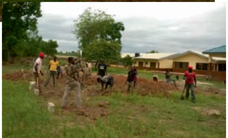
Fundamentarbeiten für das Röntgengebäude
