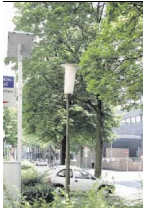
Die Uralt-Laternen in der Bahnhofstraße werden künftig ausgetauscht und auch die nicht mehr verkehrssicheren Bäume gestutzt. Doch eine Sanierung aus einem Guss liegt für die nächsten Jahre auf Eis.
