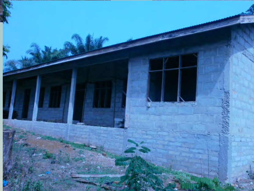
Stand der Bauarbeiten Februar 2014
