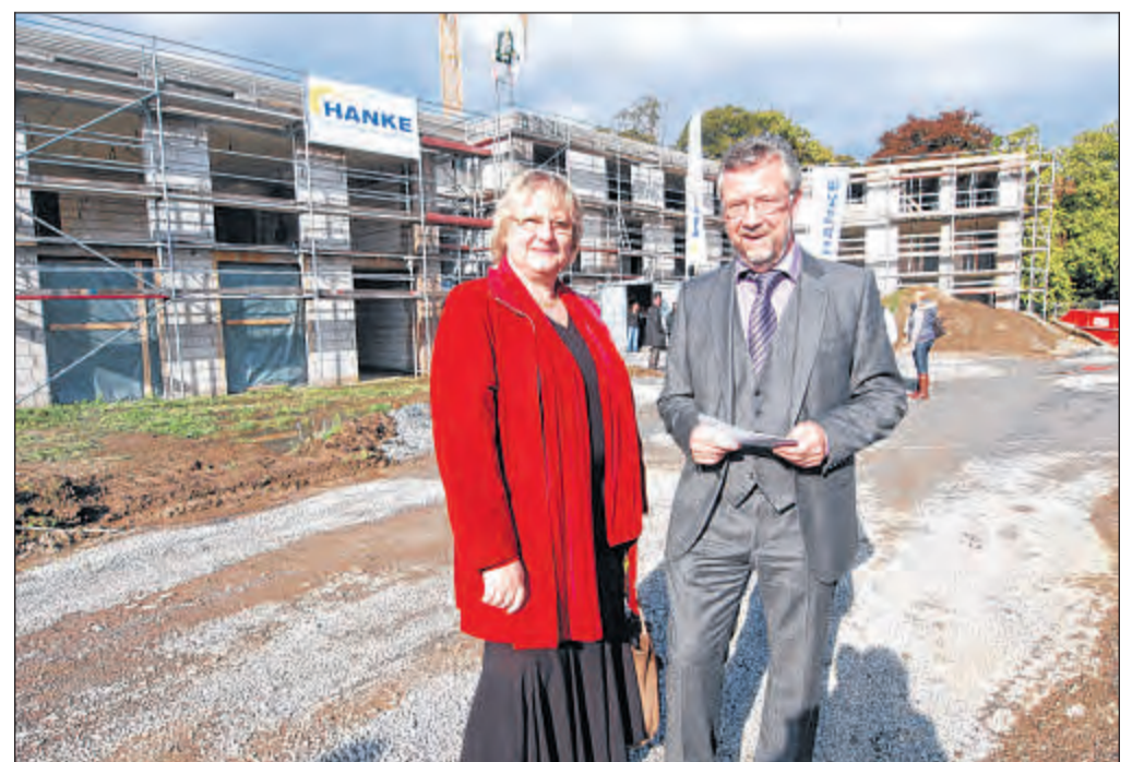
Der Richtkranz ist aufgezogen: Christine Grebe vom Fachbereich Sonderprojekte ist froh darüber, dass Investor Hermes den Bau der Seniorenresidenz zügig voranbringt. Foto: hh
